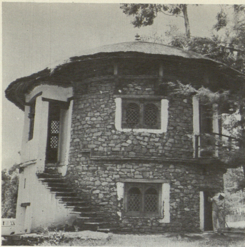
Distintos tratamientos de la piedra en edificaciones de épocas remotas.
